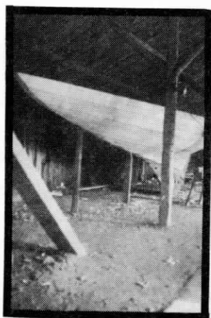
69:an under byggnad i ett repslageri i Södertälje 1935.
