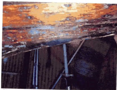
Järnsjuka från rostade järnbultar. Se nästa uppslag
